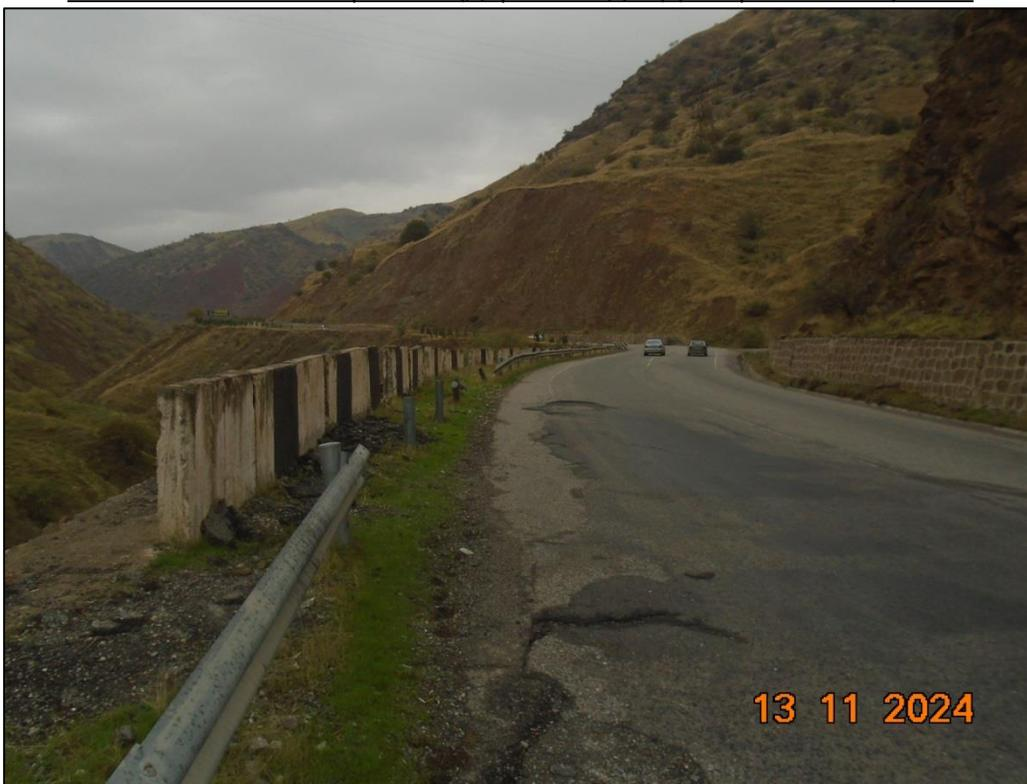
Фото 1. Км 48.4ПС. Пример недавно поврежденного ограждения, требующего срочного ремонта/замены.
