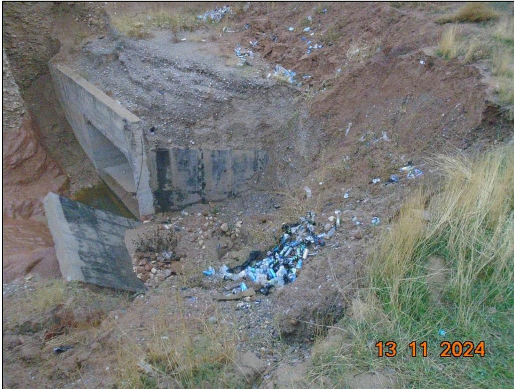
Фото 9. Км 41.2 ЛС. Пример недавно поврежденного входного отверстия водопропускной трубы и высокого края дорожной насыпи из-за размыва края дороги ливневыми потоками с большого водосбора, что потребовало восстановления упавшего укрепления, уплотненной обратной засыпки и облицовки канала рядом со входным отверстием водопропускного сооружения.
