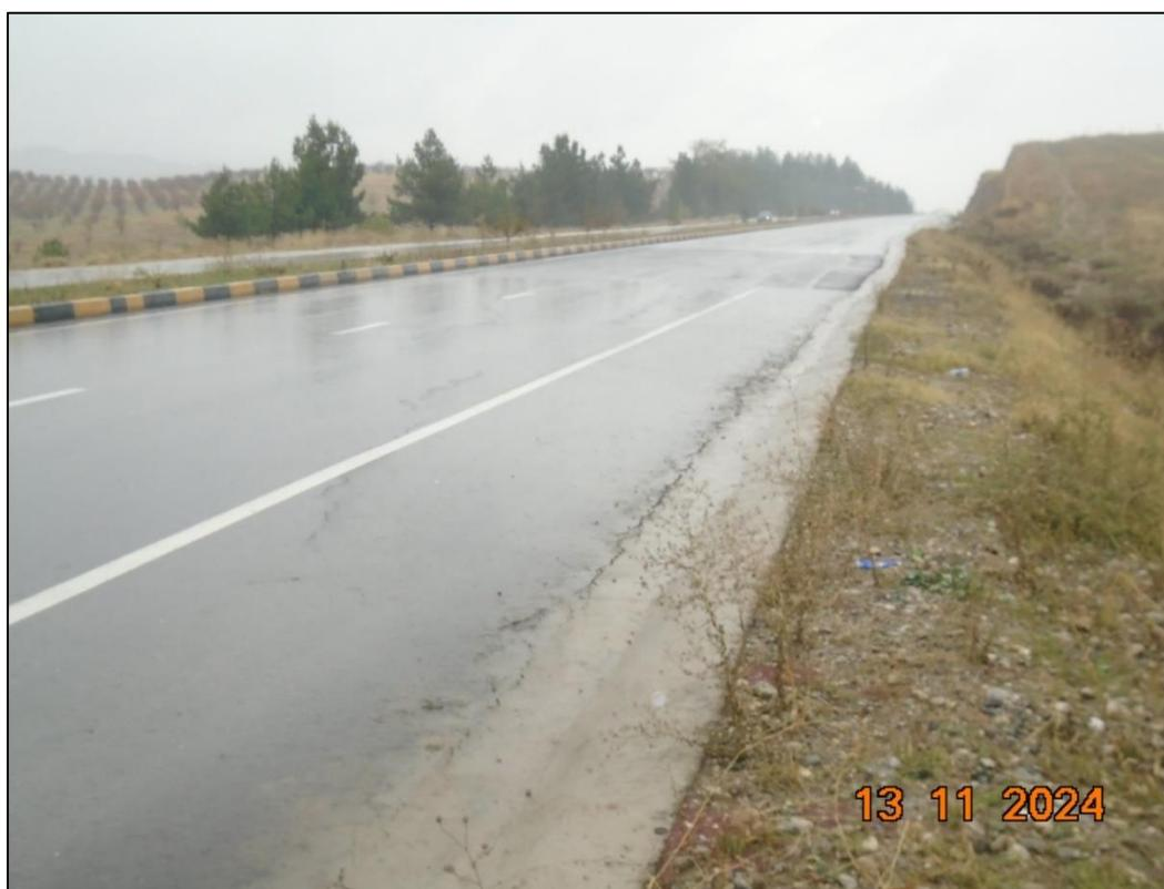
Фото 6. Км 27.2 ЛС. Пример недавней серьезной деформации дорожного покрытия из-за просадки/эрозии края дорожной насыпи, возможно, из-за сильных потоков с прилегающих полей, требующей уплотненной обратной засыпки и прокладки дренажа.
