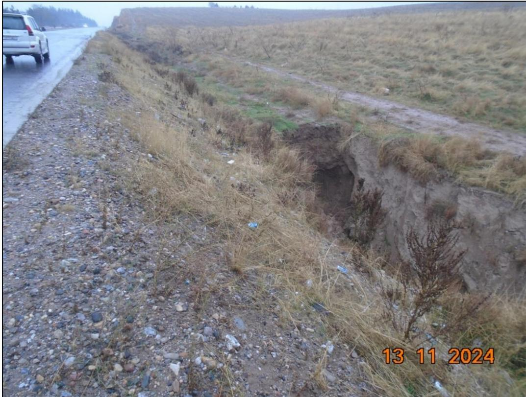
Фото 7. Крупный план трубопровода/эрозии на фото 7, возможно, из-за сильного потока с прилегающих полей, требующей уплотненной обратной засыпки и прокладки дренажа.
