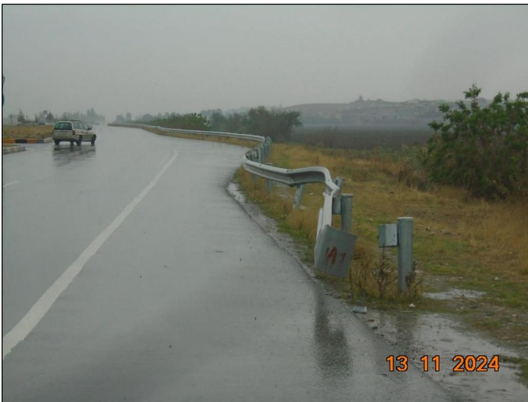
Фото 10. Км 66 ЛС. Примеры (2 шт.) недавно поврежденных ограждений, которые представляют собой новую угрозу безопасности дорожного движения, пока не будут отремонтированы/заменены.
